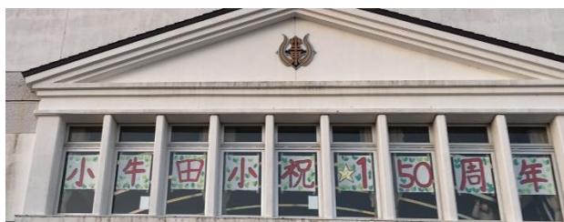
校舎南側正面2階に掲示してあります。
